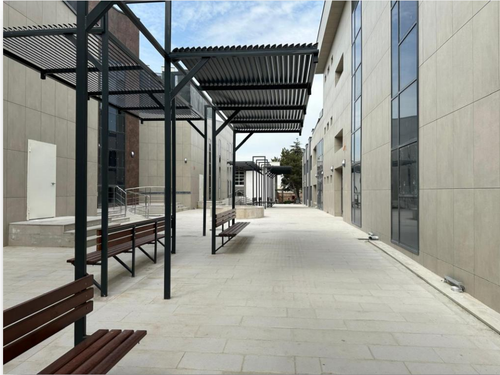
Görseller: Gülhane Külliyesi Dış Hekimliği ve Eczacılık Fakülteleri Merkezi Dersliği Yapım İşİ
