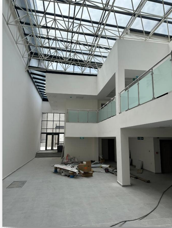
Görseller: Gülhane Külliyesi Dış Hekimliği ve Eczacılık Fakülteleri Merkezi Dersliği Yapım İşİ
