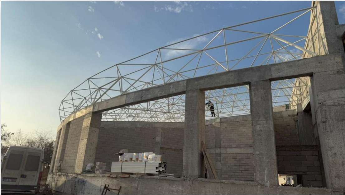
Görseller: Gülhane Külliyesi Dış Hekimliği ve Eczacılık Fakülteleri Merkezi Dersliği Yapım İşi
