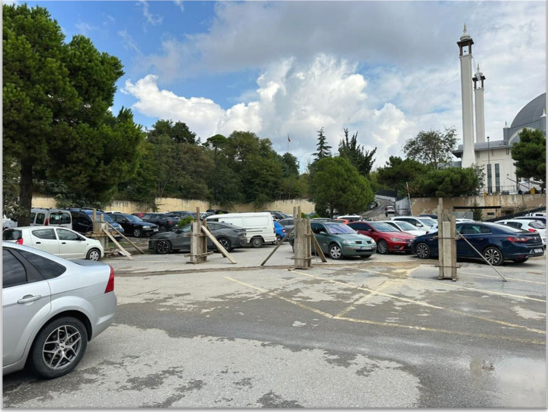
Kapalı Spor Salonu Çevre Kapaması Yapım İşi (Öncesi)
