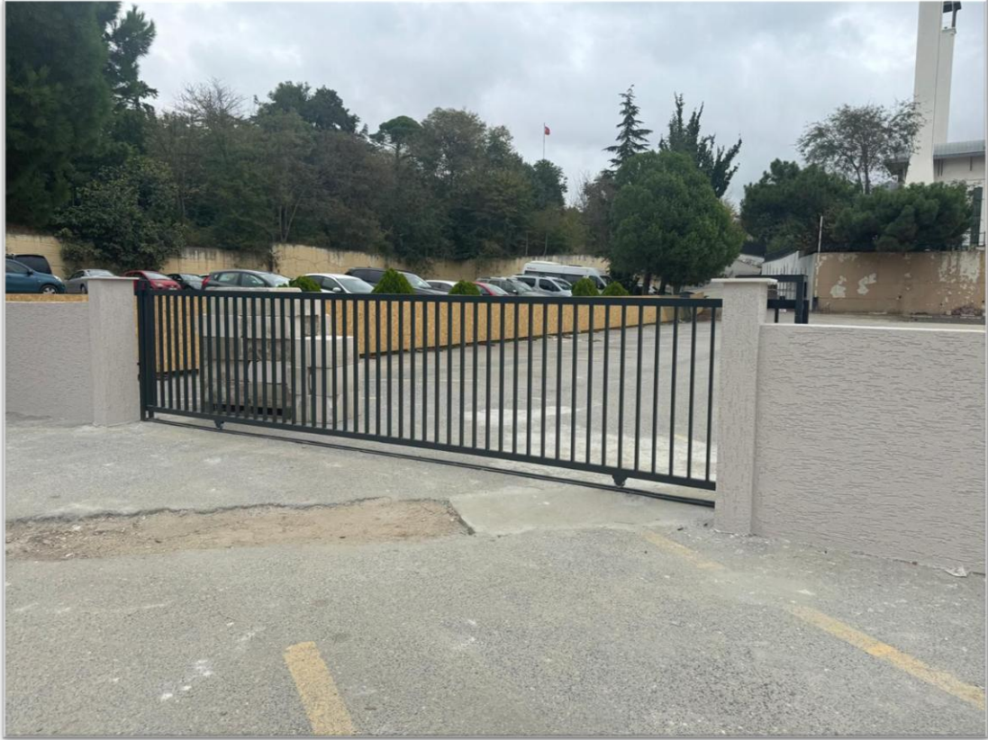
Kapalı Spor Salonu Çevre Kapaması Yapım İşi (Sonrası)
