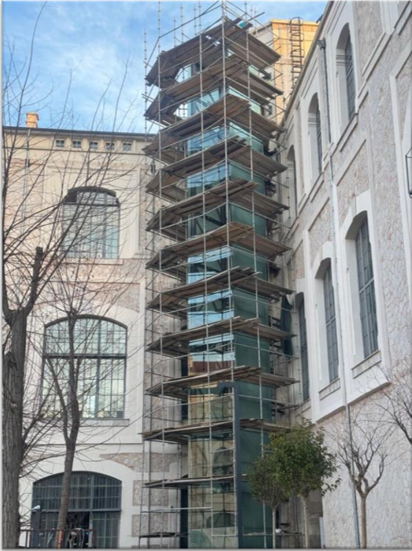
Hamidiye Külliyesi Mekteb-i Tıbbiye-i Şahane Binası 3. Etap Restorasyonu
