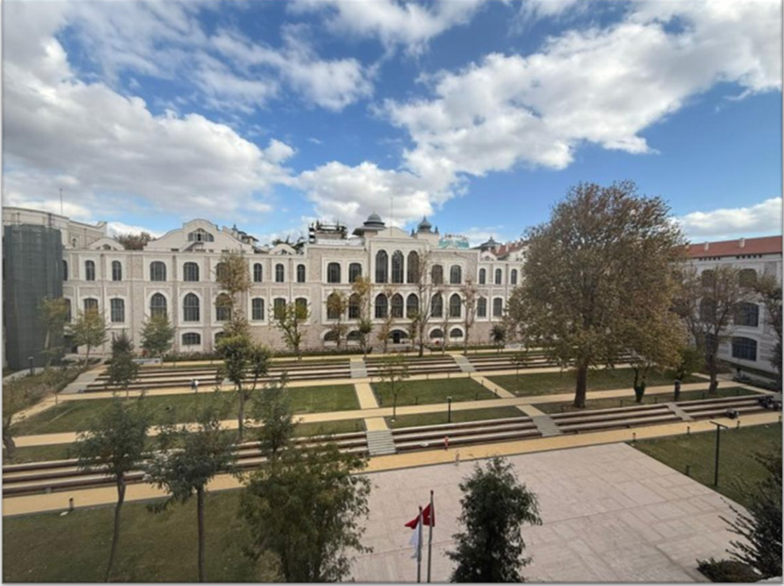
Hamidiye Külliyesi Mekteb-i Tıbbiye-i Şahane Binası 3. Etap Restorasyonu
