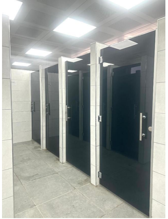
A Blok Duş-WC (Sonrası)
