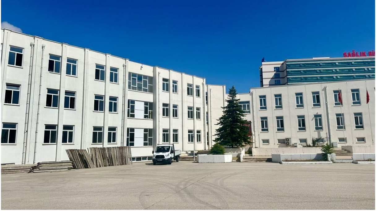
SBÜ Gülhane Külliyesi Kız Yurdu (A Blok) Binasının Tadilatı Yapım İşi (Öncesi)
