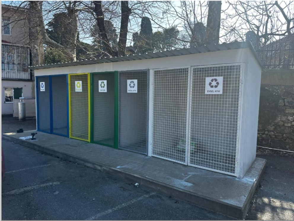
Hamidiye Külliyesi Geri Dönüşüm Geçici Atık Toplama Deposu Yapım İşi (Sonrası)
