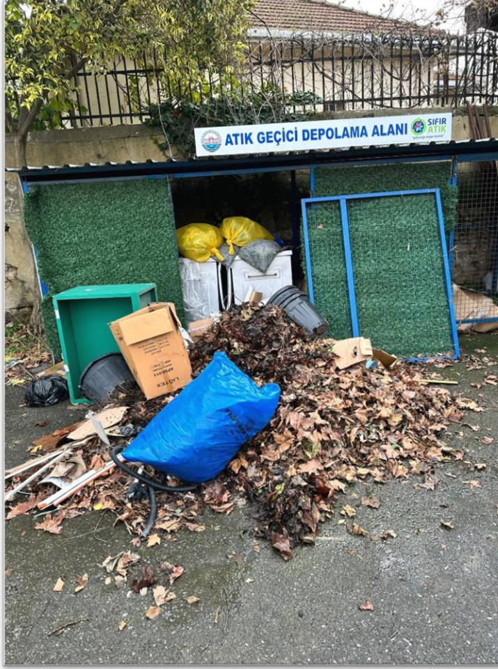
Hamidiye Külliyesi Geri Dönüşüm Geçici Atık Toplama Deposu Yapım İşi (Öncesi)
