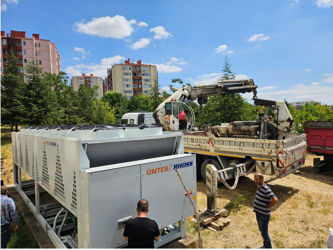
SBÜ Gülhane Külliyesi Enstitü Binası Soğutma Grubu Yenileme İşi
