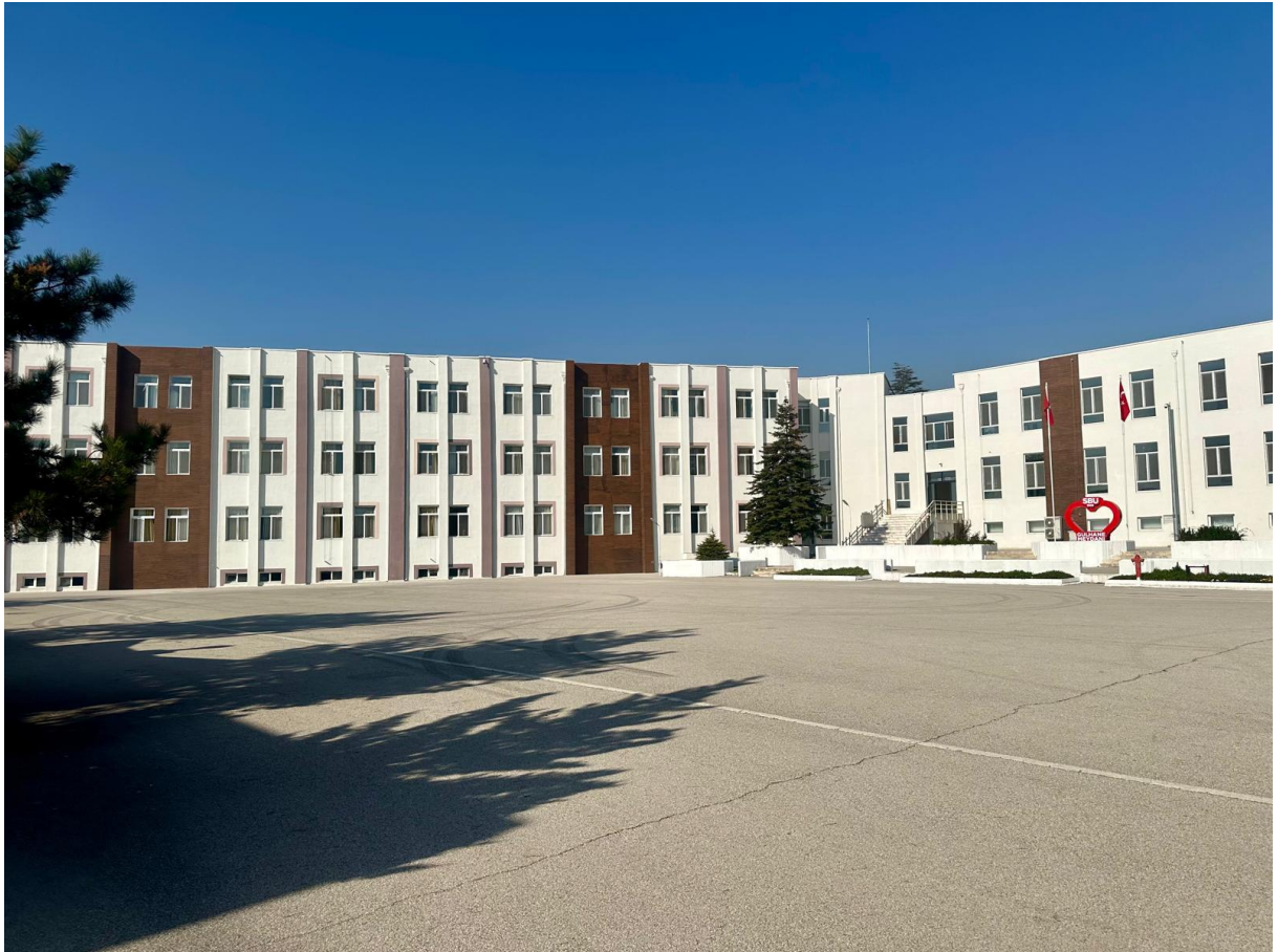
SBÜ Gülhane Külliyesi Kız Yurdu (A Blok) Binasının Tadilatı Yapım İşi (Sonrası)
