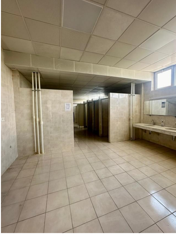
A Blok Duş-WC (Öncesi)
